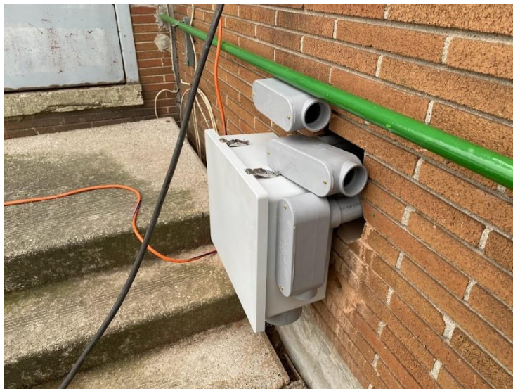
31. PVC Conduit Installation (Switchgear to Pull Box) (2021-01-05)
