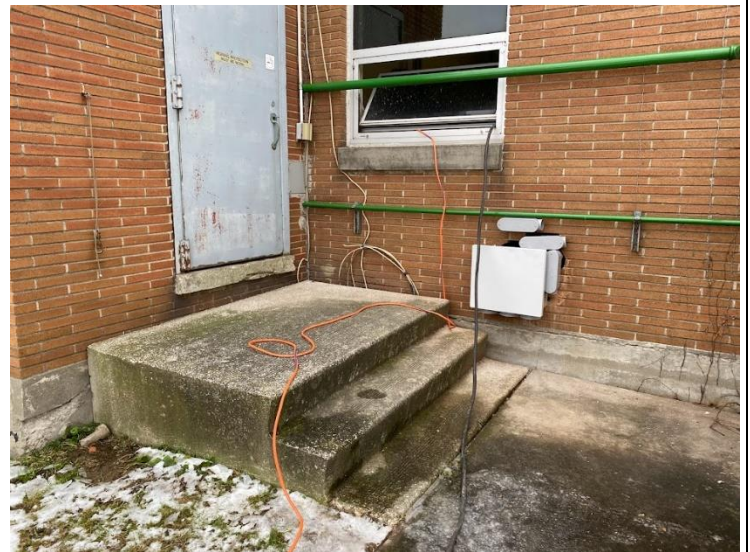
30. PVC Conduit Installation (Switchgear to Pull Box) (2021-01-05)
